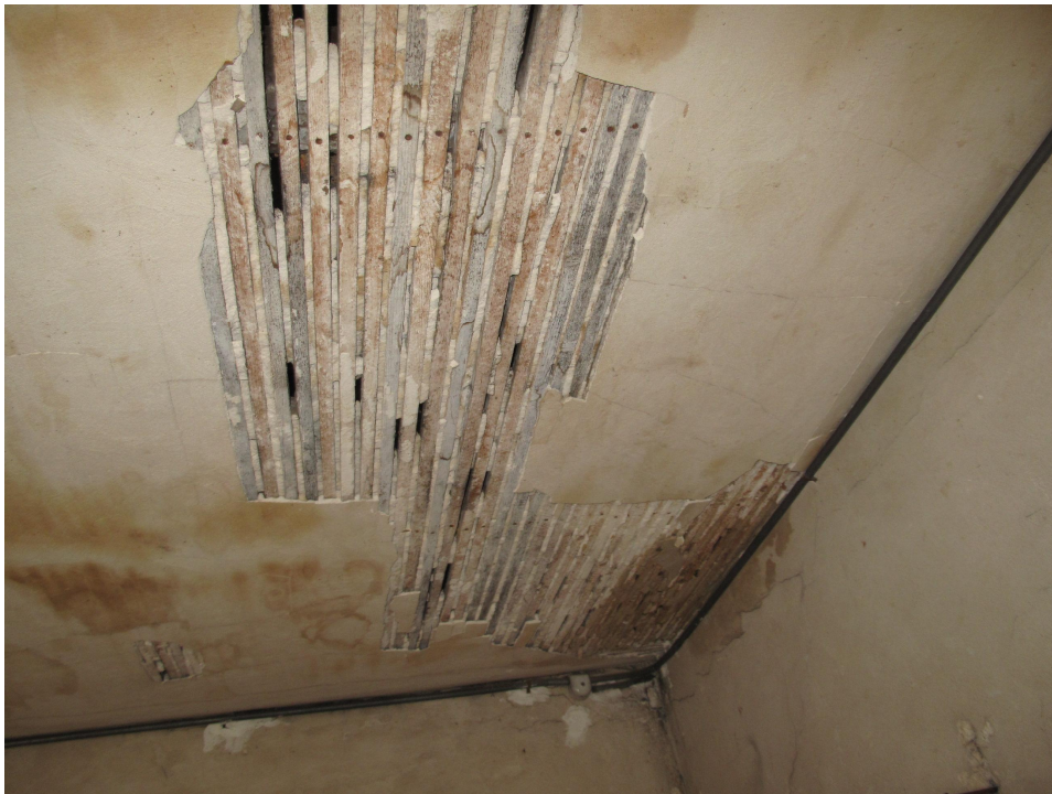
Bild 8: Spalierdecke im DG
