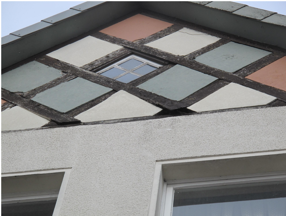
Bild 18: Zierfachwerk am Giebel Bauteil 2
