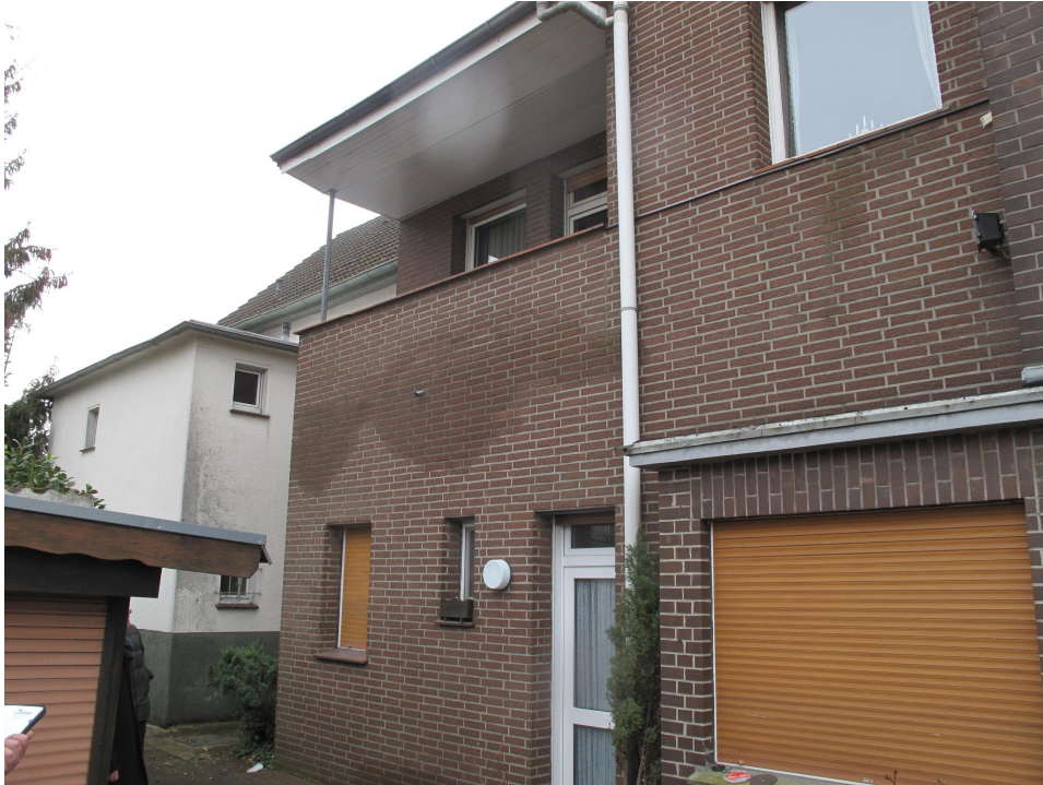
Bild 14: Klinkerfassade am Balkon
