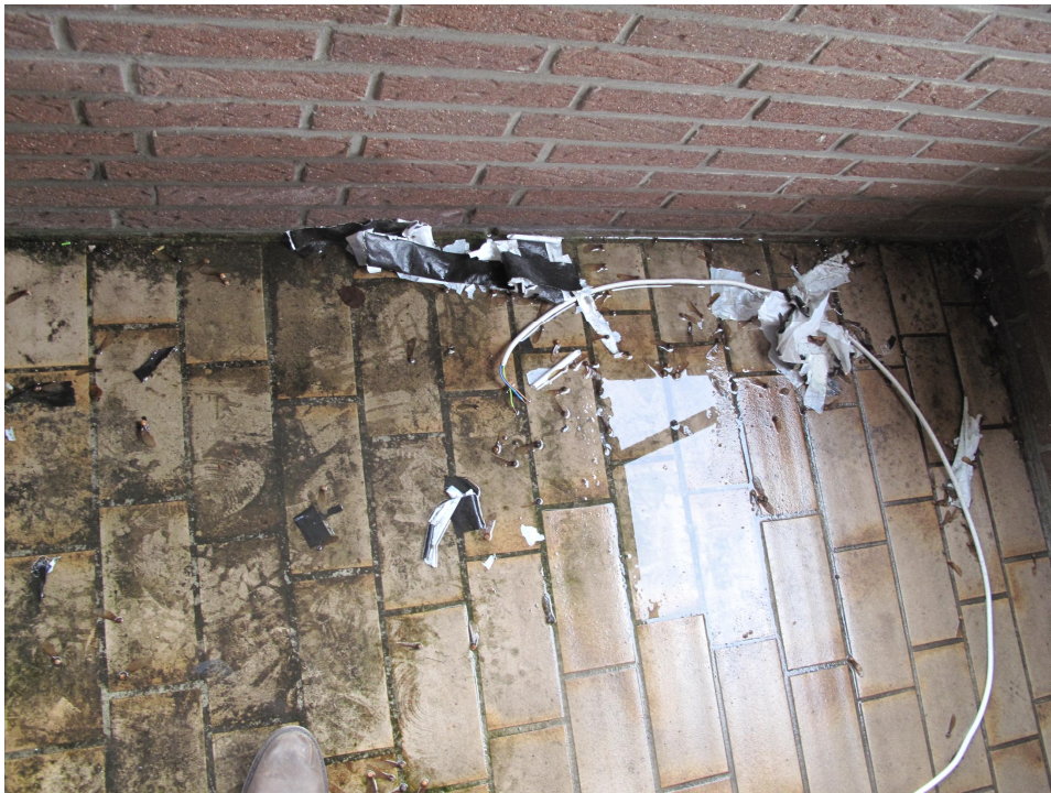
Bild 13: stehendes Wasser auf dem Balkon 1. OG
