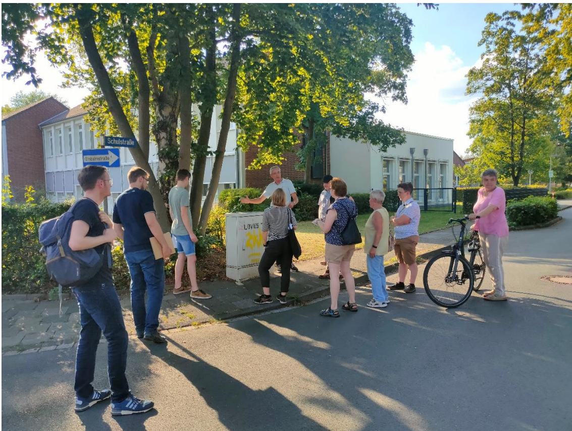
Abbildung 8: Stromkasten an der Schulstraße
